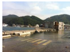
冠水した海沿いの道路
