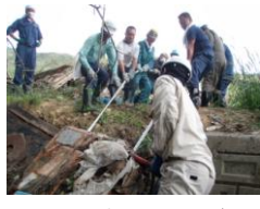
川から重量物を引き揚げ中
